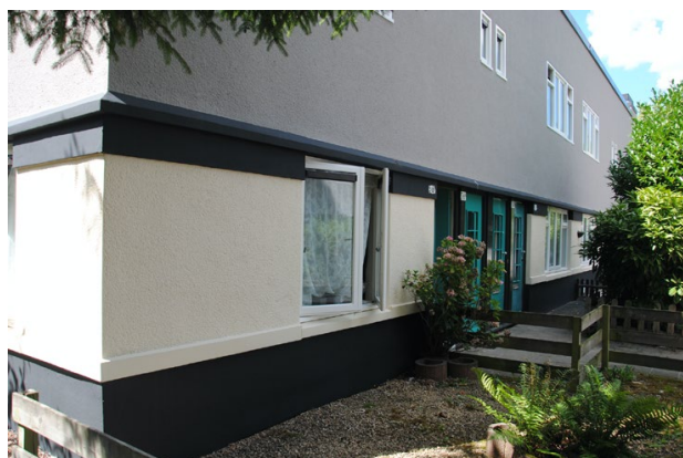
Buitenschilderwerk op beton.
