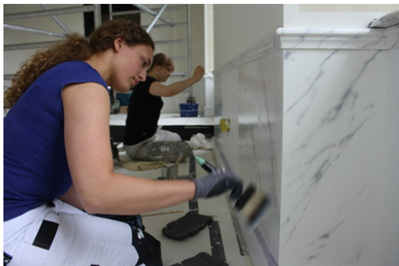
Het aanbrengen van een imitatie van witmarmer.
