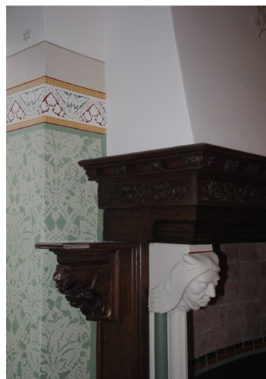
Binnenschilderwerk op steen afgewerkt met decoratief sjabloneerwerk.
