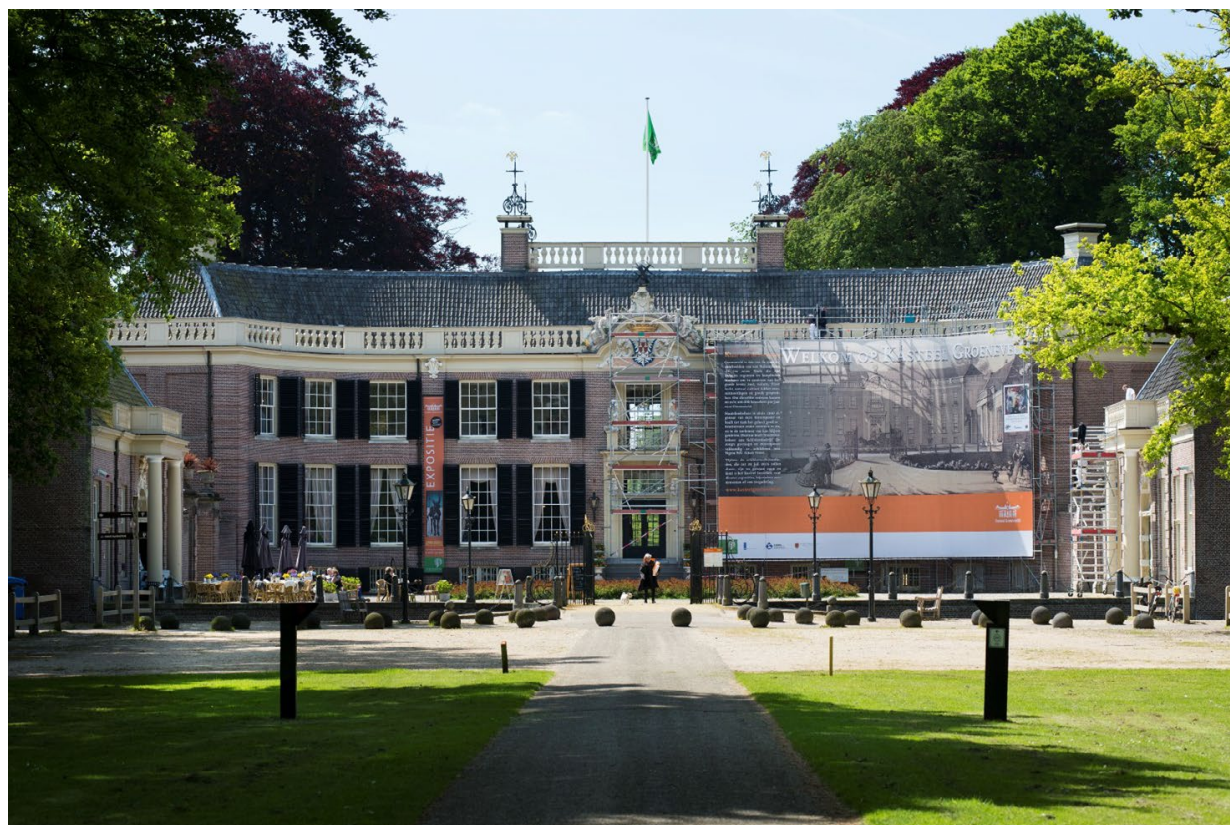
Onderhoud en restauratie van schilderwerk aan monumenten.
