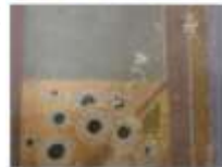
4 doorslag opgezwollen lijm en verlaag doek Z-ZW links 47
