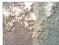
6 doorslag opgezwollen lijm en verlaag doek Z-ZW links 46
