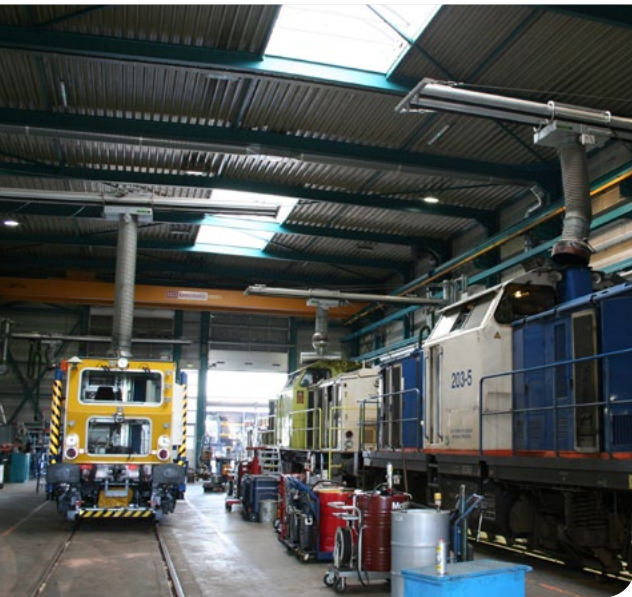
Figuur 10 Puntafzuiging in een werkplaats
