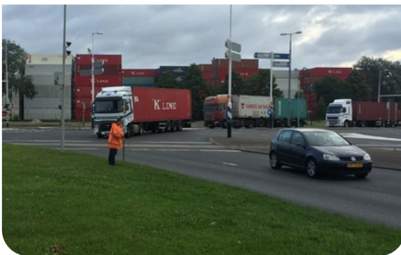
Figuur 1 Werkzaamheden in de nabijheid van langrijdend verkeer.
